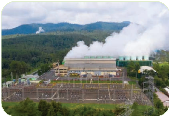
Gambar 6.18 PLTP Kamojang, Kabupaten Bandung
